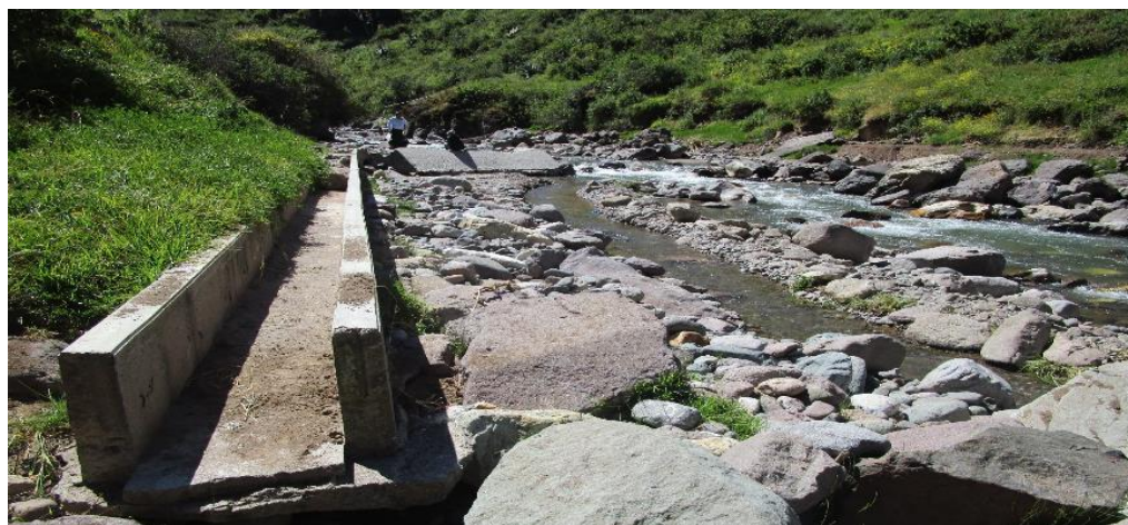
FOTOGRAFIA N°02: TRAMO CRÍTICO EN EL RIO QUITO ARMA, SOCAVANDO EL CANAL Y SU BOCATOMA, DEJANDOLOS SIN PODER CAPTAR EL RECURSO HIDRICO.
