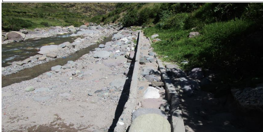
FOTOGRAFIA N°03: TRAMO CRÍTICO EN EL RIO QUITO ARMA DONDE SE APRECIA COLMATADO EL CANAL DE RIEGO.
