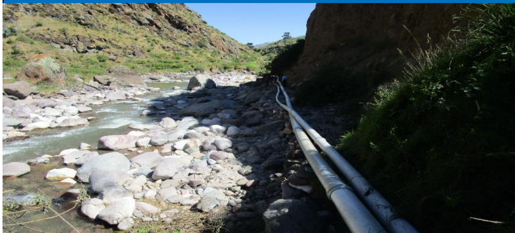
FOTOGRAFIA N°01: TRAMO CRÍTICO EN EL RIO QUITO ARMA, EROSIANDO AL CANAL PERPETUO SOCORRO Y SAN ISIDRO LABRADOR, AFECTANDOLO.
